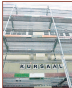
Jetzt kann's losgehen – das Gerüst steht.
