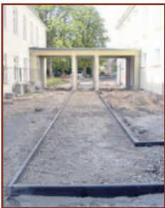
Künftig Eingang: Der freigelegte Säulengang.
