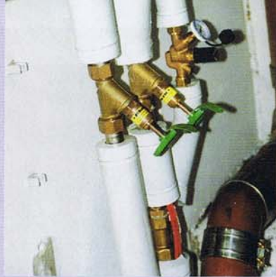
Die Montage erfolgte schnell und eichflach.
