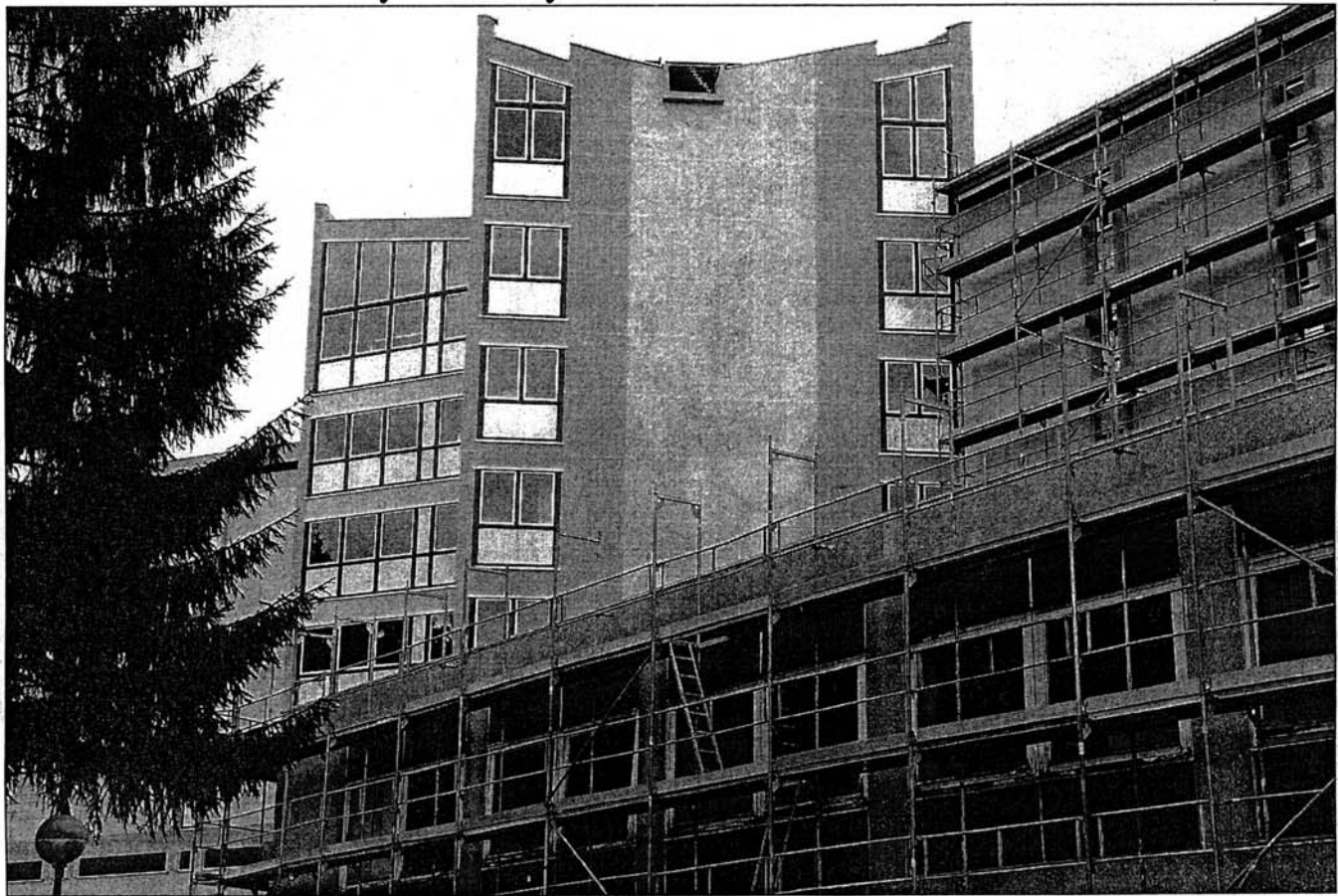
Äußerliche Zeichen des Baufortschritts gibt es bereits mehrere: Neue Fensterfronten, ein Großauftrag für das Clausthal-Zellerfeld Unternehmen Klose Fenstertechnik, und die Überarbeitung der Fassadenplatten aus Waschbeton geben dem Gebäudekomplex ein besseres Erscheinungsbild. Fotos: Bertram
