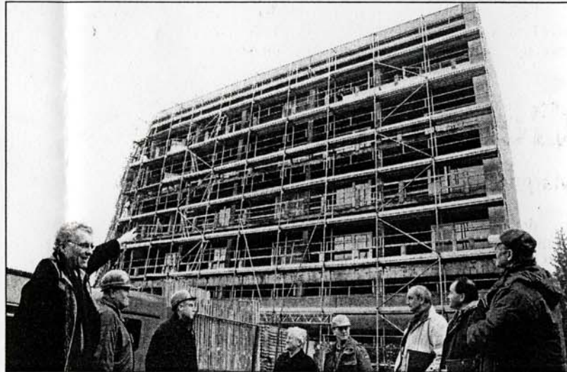
Die Südseite des Haupthauses ist bereits eingerüstet: Investor Hans-Joachim Schneider (l.) bei der Baustellenbesichtigung mit Fachleuten aus Handwerk und Bauleitung. Foto: Bertram
